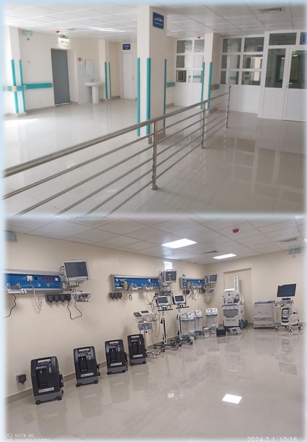
مبنى مركز الحميات من الداخل أثناء التجهيزات
